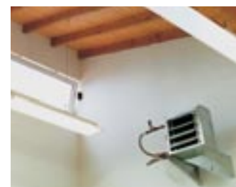
При открывании верхних окон вентиляторные обогреватели автоматически выключаются в теплое время
