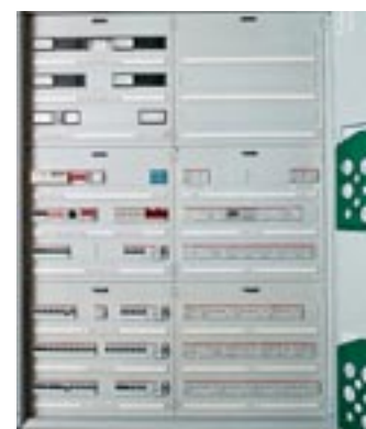
Шкаф управления со стандартным оборудованием и устройствами EIB
