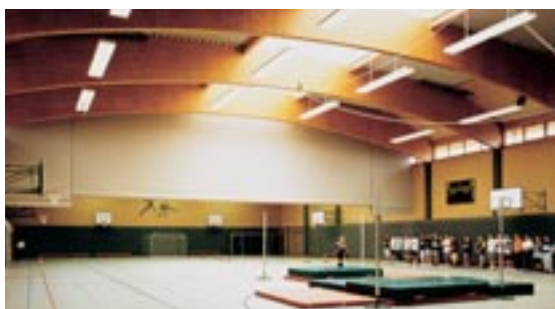
Помимо освещения, через EIB происходит управление другими функциями, в число которых, например, входит открывание/закрывание разделительной шторы и опускание канатов.
